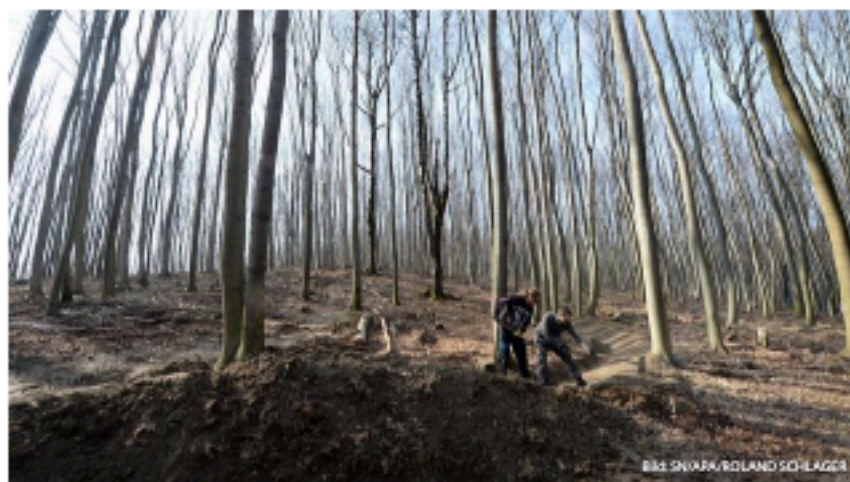
Bau der Mountainbikestrecke im Weidlingbachtal in Klosterneuburg.
